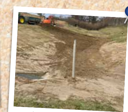
Rückhaltebecken ausbaggern
